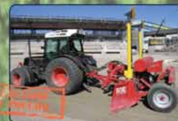
ЛАЗЕРНАЯ ПЛАНИРОВКА ОСНОВАНИЯ
