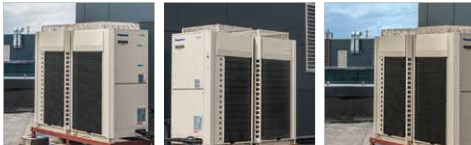
● «Иннополис». Верхнеуслонский район Татарстана. Общая холодильная мощность — 325 кВт Наружные блоки — 10 Внутренние блоки — 42
