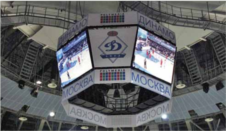
Медиакуб, состоящий из четырех полноцветных светодиодных экранов размером 3х4 метра, двумя табло для отображения счета и состава команд, системой судейства.
