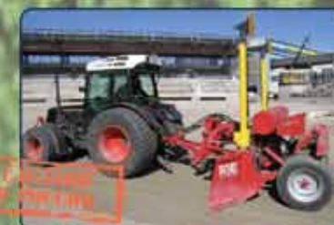
ЛАЗЕРНАЯ ПЛАНИРОВКА ОСНОВАНИЯ
