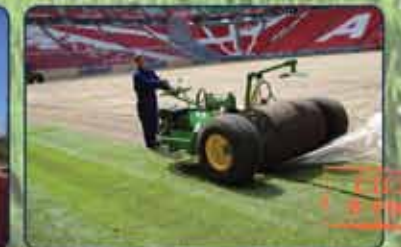
УСТРОЙСТВО НАТУРАЛЬНОГО ГАЗОНА (ПОСЕВ, НАСТИЛ)
