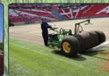
УСТРОЙСТВО НАТУРАЛЬНОГО ГАЗОНА (ПОСЕВ, НАСТИЛ)
