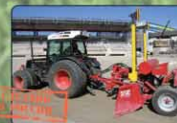
ЛАЗЕРНАЯ ПЛАНИРОВКА ОСНОВАНИЯ
