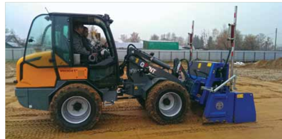
◆ Вертикальная планировка оснований спортивных площадок лазерным планировщиком.
