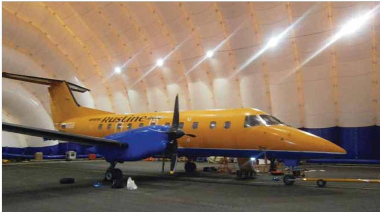
● Пневмокаркасное сооружение. Ангар для реактивного пассажирского самолета Bombardier CRJ (г. Екатеринбург, международный аэропорт «Кольцово»). Площадь покрытия: 1 370 кв.м.
