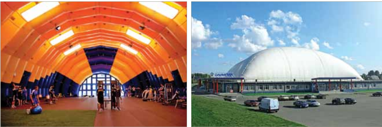
● Пневмокаркасное сооружение. Спортивный комплекс для тренировки основного состава футбольной команды «БАТЭ», тренажерный зал (Белоруссия, г. Борисов). Площадь сооружения: 820 кв.м.
