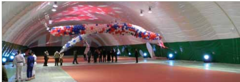
● Пневмокаркасное сооружение. Ангар для реактивного пассажирского самолета Bombardier CRJ (г. Екатеринбург, международный аэропорт «Кольцово»). Площадь покрытия: 1 370 кв.м.
