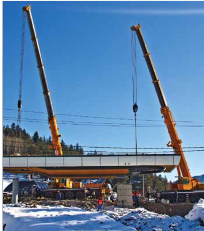
Уникальный монтаж станции канатной дороги в сборе. Архыз, декабрь 2012
