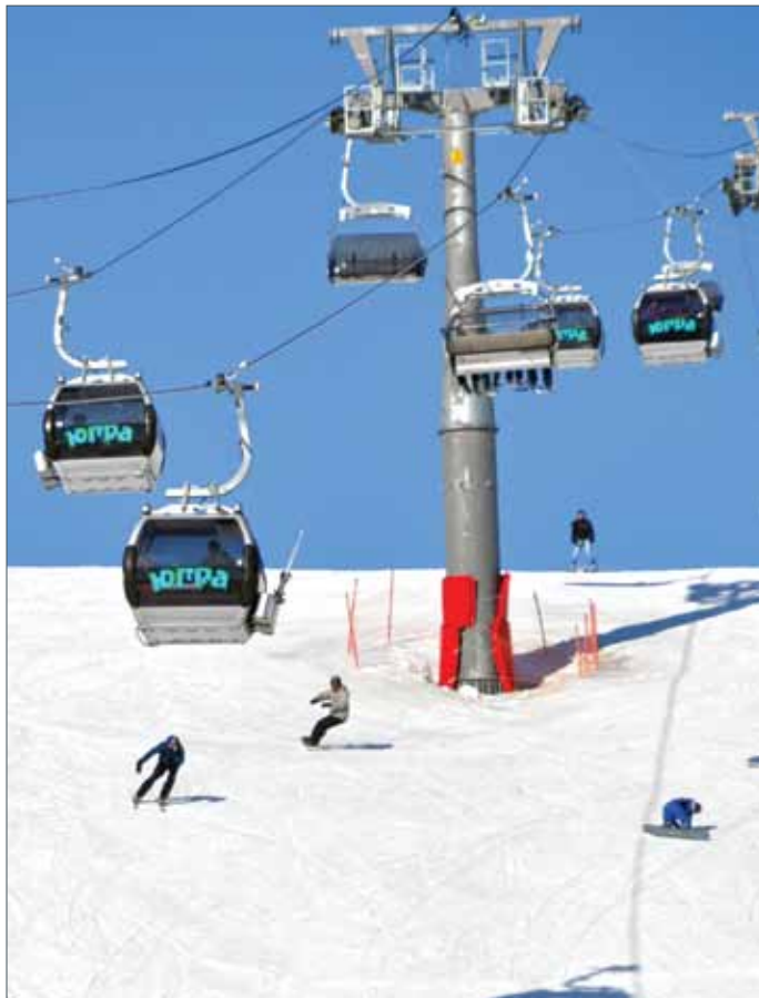
Оборудована комбинированной канатной дорогой, состоящей из закрытых восьмиместных гондол и открытых четырехместных кресел
