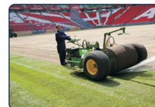
УСТРОЙСТВО НАТУРАЛЬНОГО ГАЗОНА (ПОСЕВ, НАСТИЛ)
