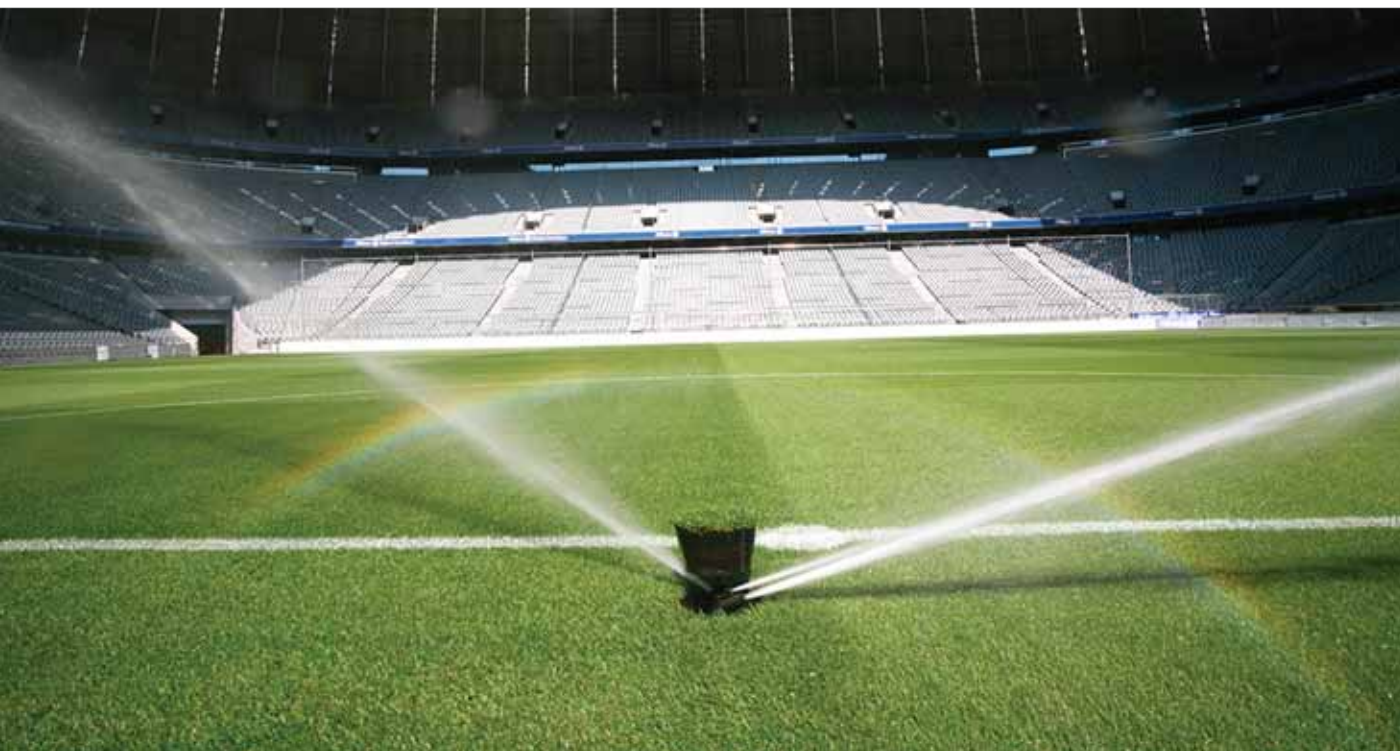
❶ Система полива PERROT футбольного поля на ALLIANZ ARENA Мюнхен.
