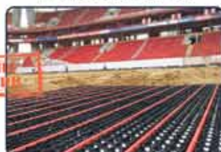
СИСТЕМА ПЛОСКОСТНОГО ДРЕНАЖА „MEGAGRIED“
