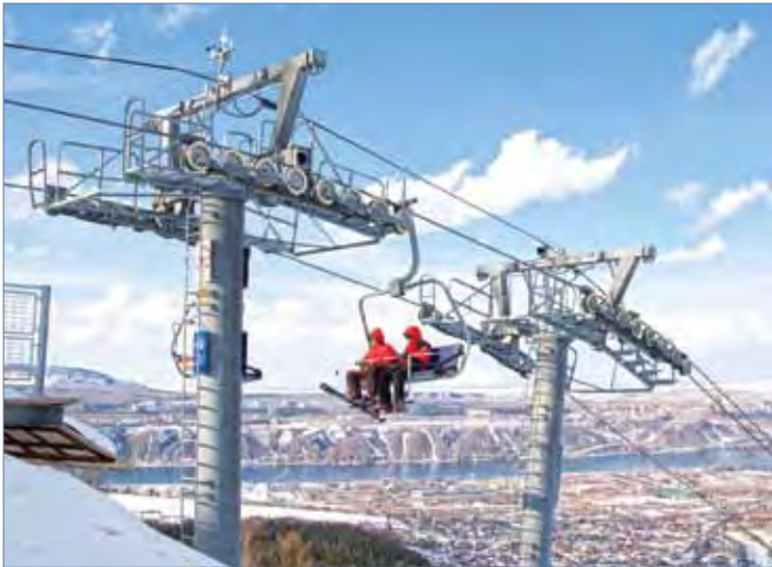
☞ Для подъема посетителей на вершину трасс установлены два четырехместных канатно-кресельных подъемника.
