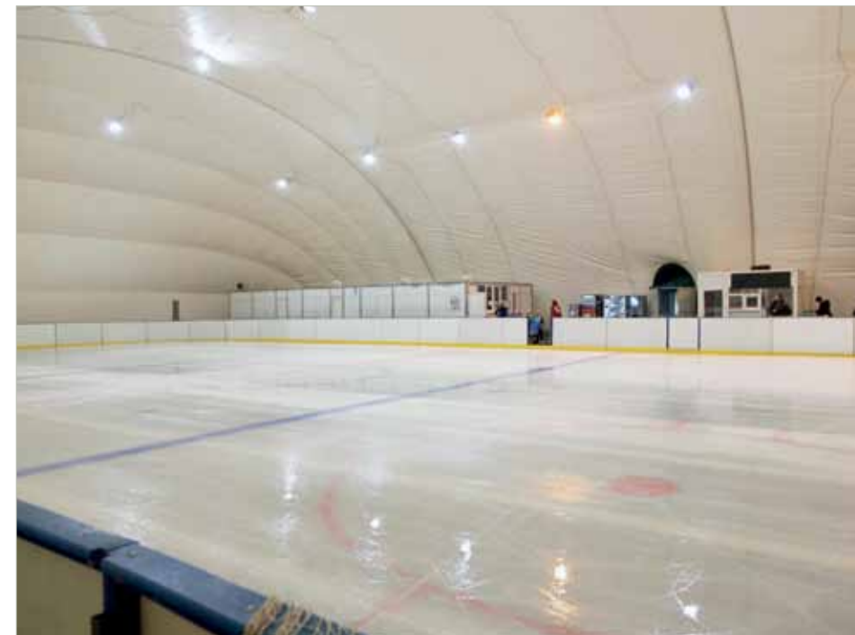
«Многофункциональная спортивная площадка на базе пневмокаркасного сооружения. Общая площадь сооружения — 1500 кв.м, г. Ялта, пос. Гурзуф.
