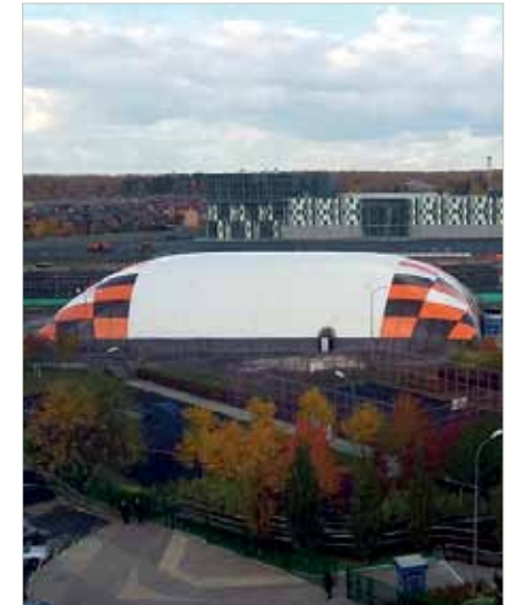
«Многофункциональная спортивная площадка на базе пневмокаркасного сооружения. Общая площадь сооружения — 1500 кв.м, г. Ялта, пос. Гурзуф.
