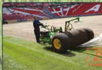
УСТРОЙСТВО НАТУРАЛЬНОГО ГАЗОНА (ПОСЕВ, НАСТИЛ)
