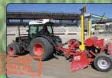
ЛАЗЕРНАЯ ПЛАНИРОВКА ОСНОВАНИЯ
